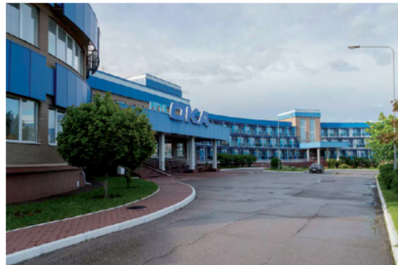
Тульская область, г. Алексин, РУТБ «ОКА»
